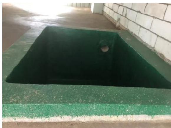
危废间收集井
