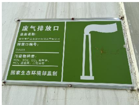
3号焚烧炉废气排放口环保标识牌
