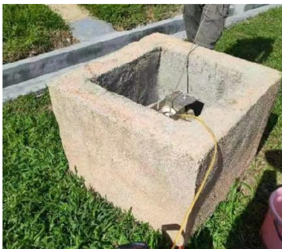
地下水监测井
