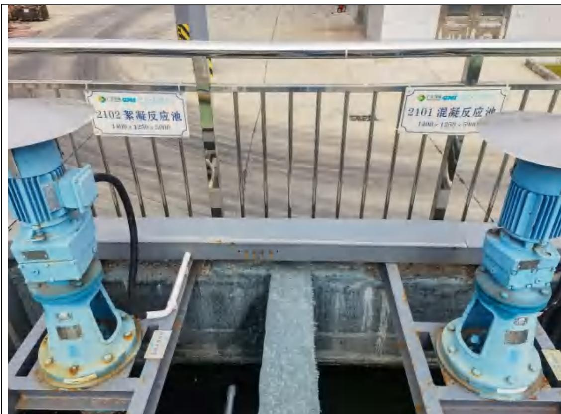
絮凝反应池、混凝反应池
