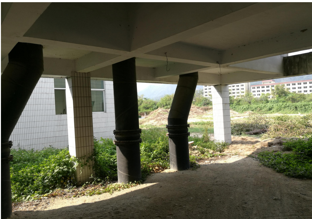
图 1-2 市区污水处理厂提升泵房出水管
